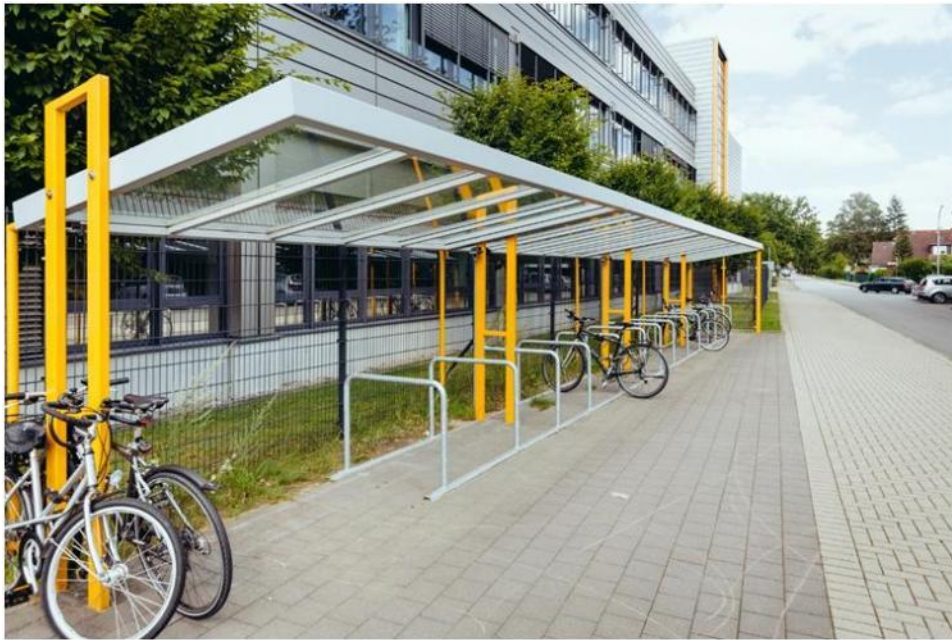
ABBILDUNG 29: BETRIEBLICHE RADABSTELLANLAGE IN NORDERSTEDT (EIGENES FOTO)
