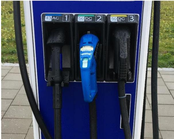
Abbildung 6: Beispiel einer Ladestation – Schnelllader Mode 3 und Mode 4 (Quelle: Eigene Darstellung)
