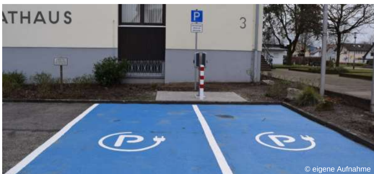
Abbildung 3-21: Ladesäule am Rathaus in Ötigheim
