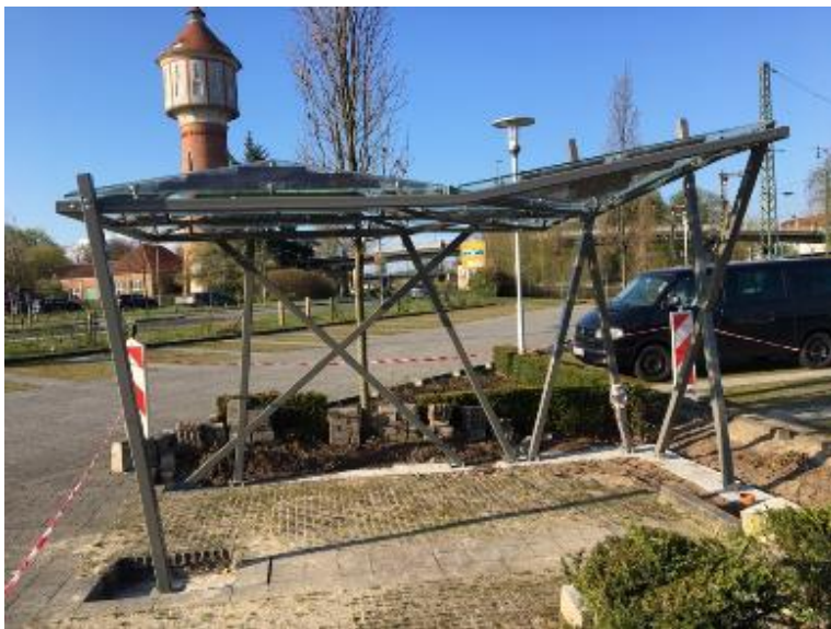
Abbildung 70: CarPort am Hochschulstandort Lingen
