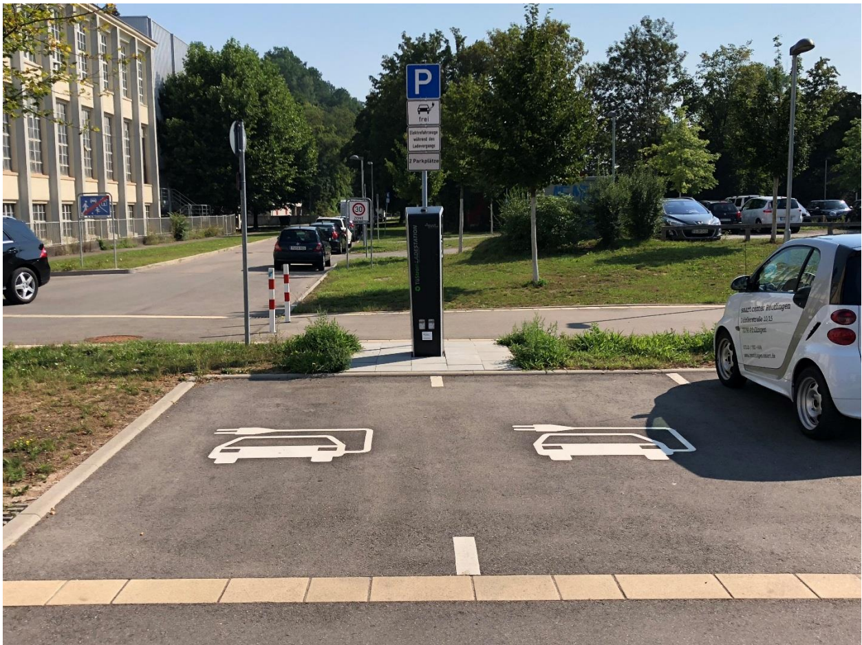
Abbildung 9 Ladesäule Egeria/Alte Weberei mit Markierung und Positiv-Beschilderung
