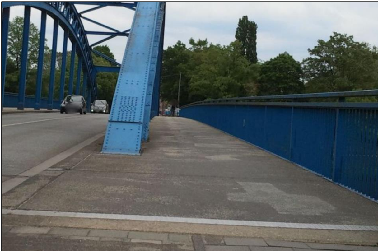
Abbildung 34: Weser Brücke – Gehweg für Radfahrer frei 148
